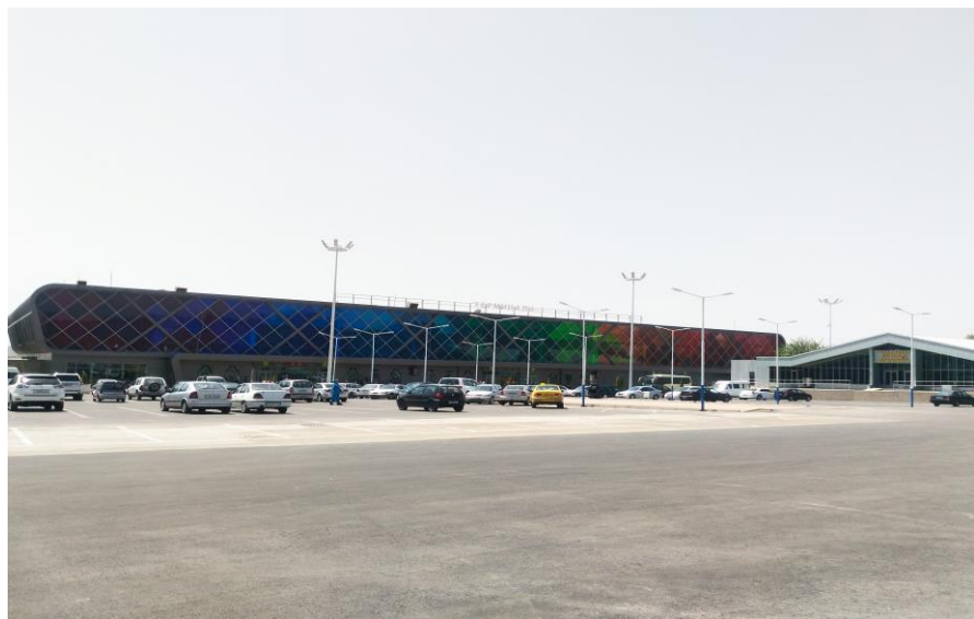
杜尚别机场新航站楼
